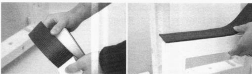
5. Das Band an der oberen Ecke mit Überstand (oberes Fugenmaß) abtrennen und bündig mit der Blendrahmenseite in der Ecke stumpf stoßen. Am Ende der Rolle stumpf stoßen und jeweils die letzten und ersten 2 cm abtrennen. Stoßfugen/Ausbrüche sind ggf. mit einer geeigneten Dichtungsmasse (z.B. compane Folienkleber CK-7012) auszufüllen.
